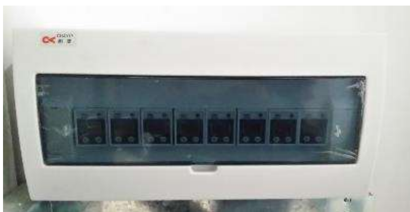
图 9 安装的三级计量电表（办公室用电计量）
