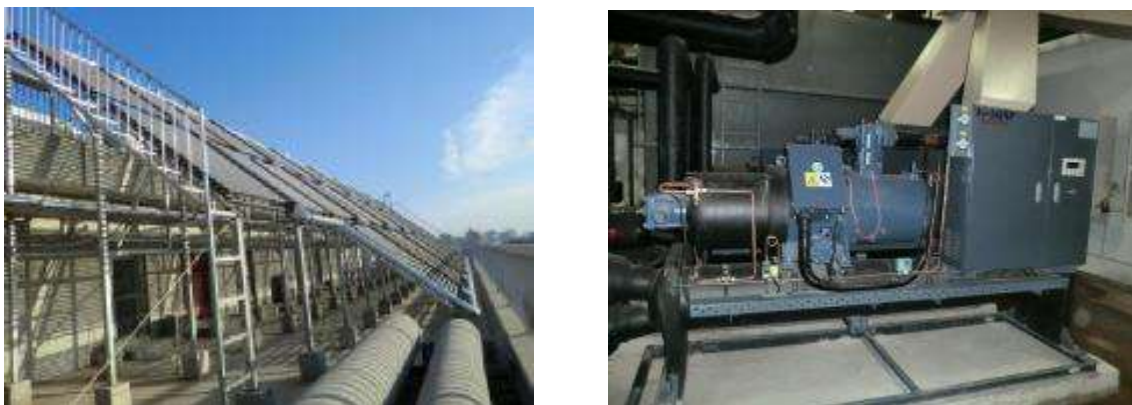
图 6 浴室太阳能及余热回收系统
