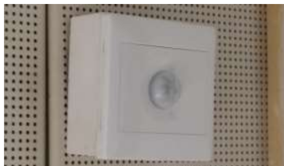
图 5 行政办事中心内安装的声控开关
