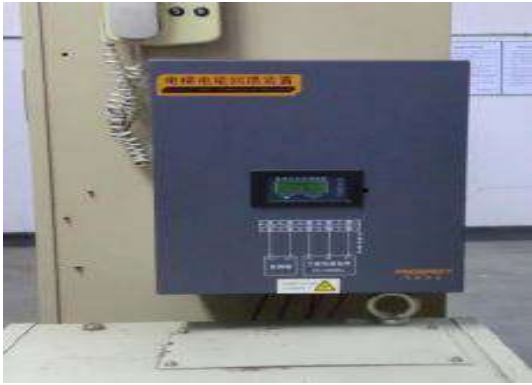
图 7 电梯能量回馈装置
