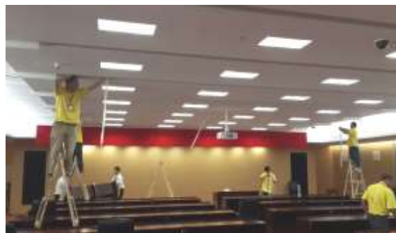
图 4 LED 灯改造现场
