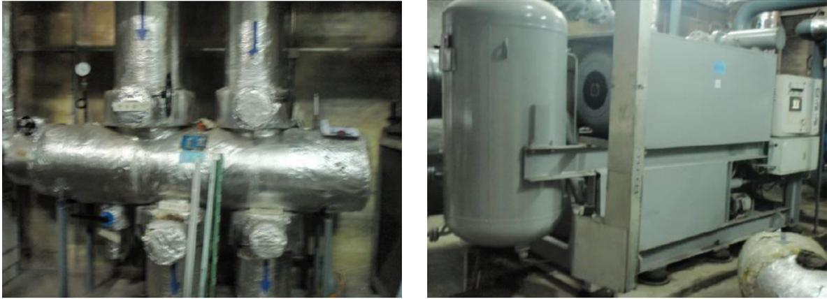
图 1 第三教学楼水源热泵机组和分集水器
