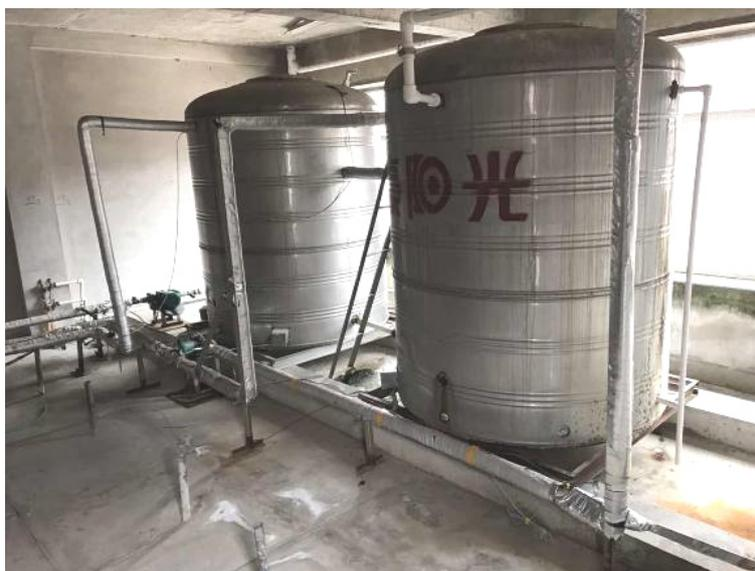
图 2 太阳能储水罐
