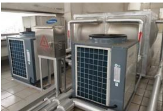
图 3 空气源热泵热水系统
