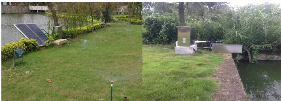
图 5 太阳能绿化自动喷淋灌溉系统
