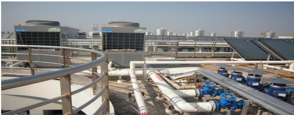
图 4 太阳能集热系统与空气源热泵耦合的热水系统
