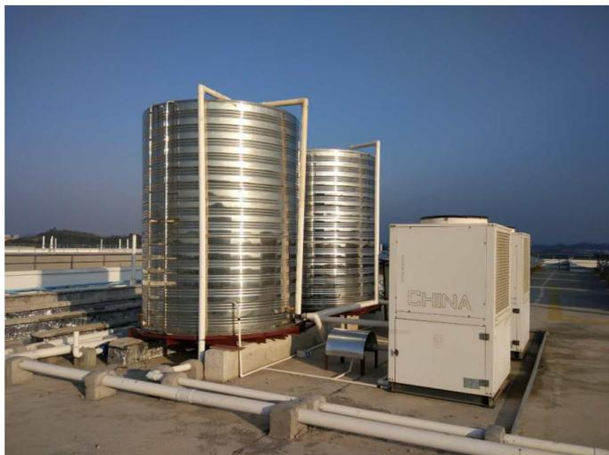
图 5 空气源热泵系统
