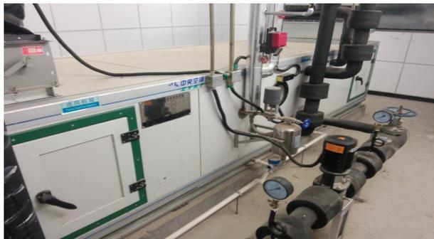
图7 空调系统排风溶液热回收系统
