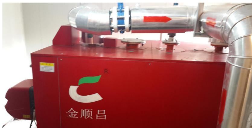
图 8 直燃式燃气机组
