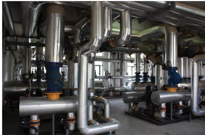
图 7 热交换站冷凝水回收装置
