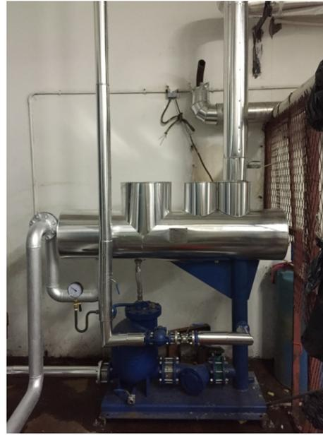
图 8 冷凝水回收装置
