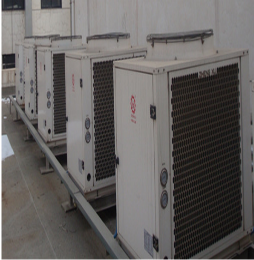
图 7 热泵机组
