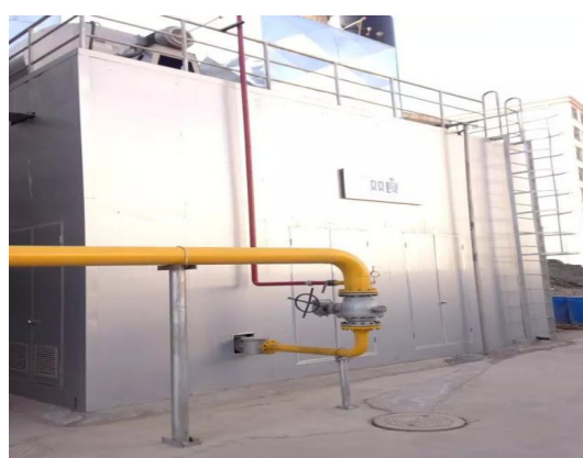
图 11 燃气锅炉常温排烟余热回收装置
