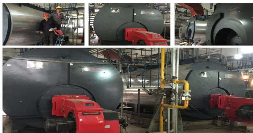
图 5 热力中心节能锅炉改造完成
