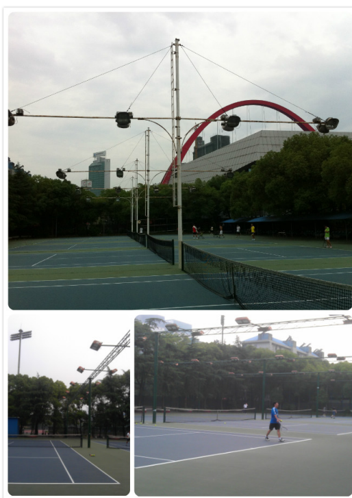
图 10 室外网球场 LED 照明产品改造前后对比图
