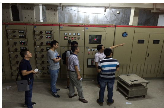
图 13 供电公司现场勘察并网电表安装位置
