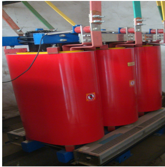
图 5 干式变压器
