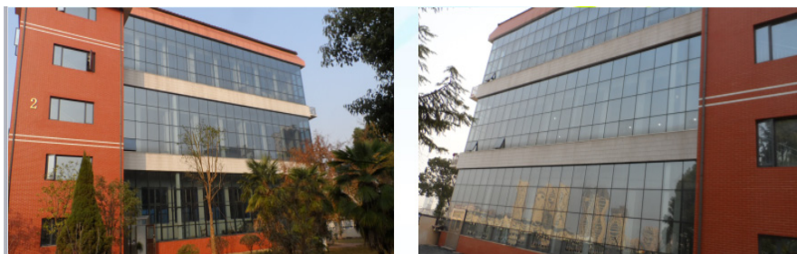
图 20 重竞技中心中空玻璃改造
