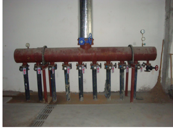
图 3 水源热泵 18 口回水管
