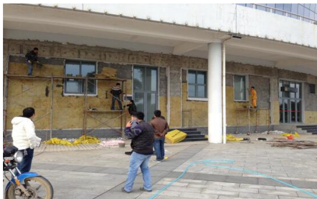
图 17 奥体中心墙体改造
