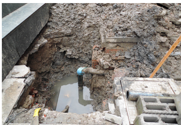
图 11 水平衡精确定位漏点
