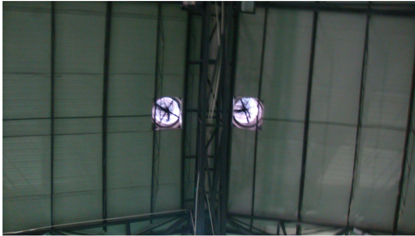
图 6 免电力涡轮通风器
