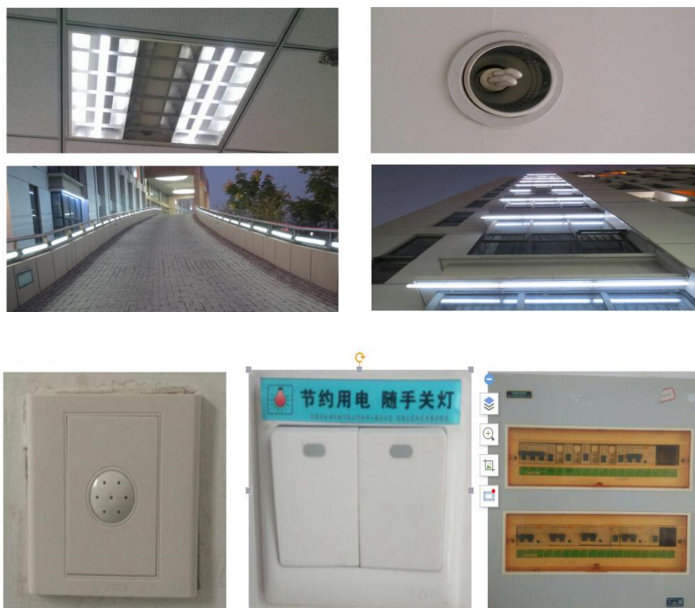
图 10 节能高效光源以及智能控制设施
