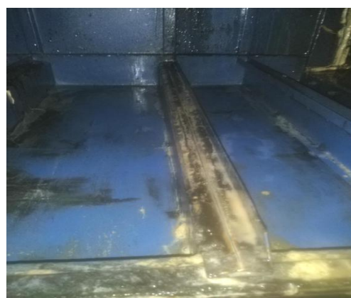
图 53 烟道清洗后照片
