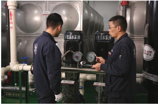
图 20 巡查供水设备
