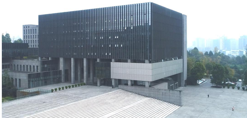
图 2 行政中心 1 号楼玻璃幕墙
