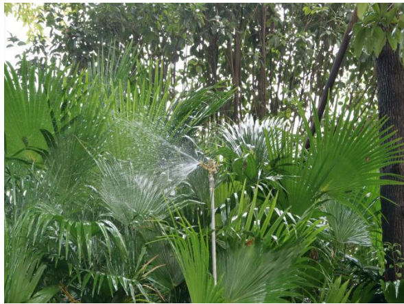
图 31 绿化采用中水高效喷灌
