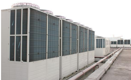
图 7 一级节能变频空调室外机
