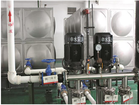
图 29 中水回用设施设备
